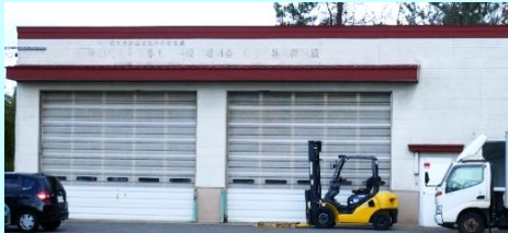
ネギの出荷調整作業施設
